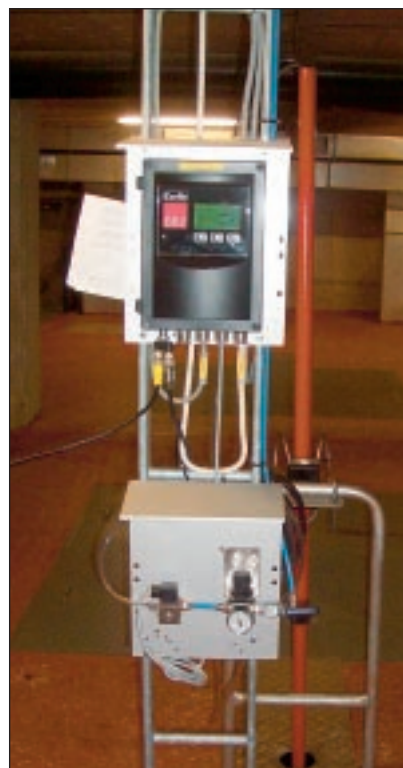
På Umeva i Umeå styrs kemikaliedoseringen med Cerlics susphalmsmätare BB2/ITX
