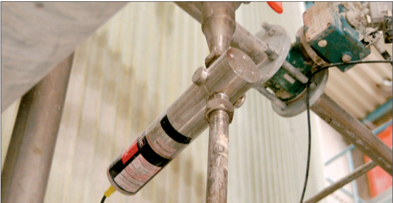
Cerlics mätare CTX 20/25 håller koll på funktionen hos grönlutsklarnare och grönlutsfilter.
