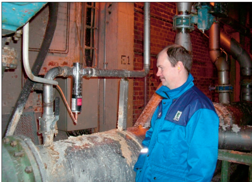
Jari Räsänen är automationsansvarig på UPM Kymmene Tervasaari. Cerlics genomströmningssgivare CTX20/50 sitter på ledningen in till virvelrenaren.
