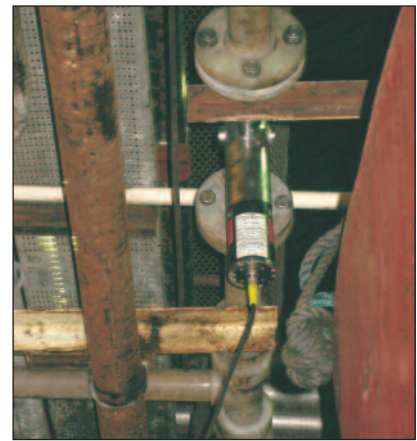
Suspahaltsmätaren på reningsanläggningen i Bergen säkerställer att endast rent vatten går vidare till utloppet och recipienten.
