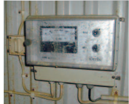
Ultraljudsmätaren ALM 20 från 1979, nött av tidens tand, fortsätter att mäta nivån i ett kemikaliekar på Krylbo reningsverk i Avesta.
